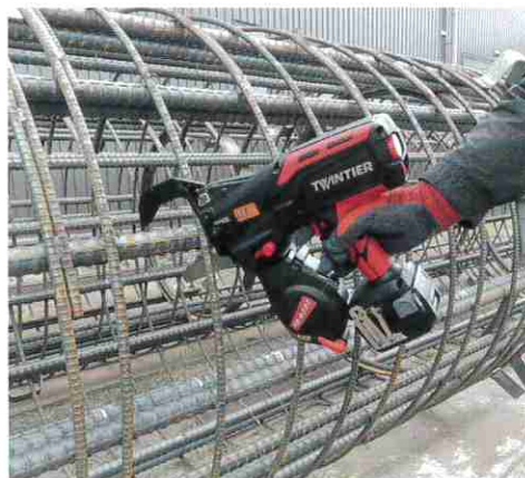
場所打ち杭 鉄筋かご 3層組 D32×D32×D13
