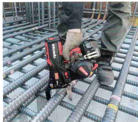
土木工事 橋梁 フーチング D51×D32
