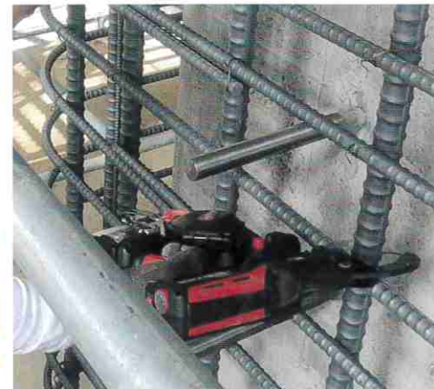
土木工事 橋梁 補強工事 D38×D22
